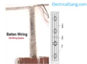
Fig. 10.19: Batten Wiring
