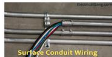
Fig. 10. 21: Surface Conduit Wiring
