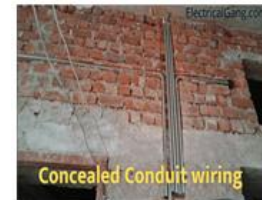
Fig. 10.20: Concealed Conduit Wiring
